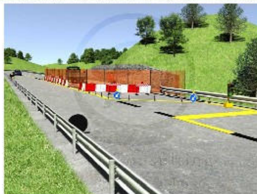
Barriera di cantiere con traffico alternato con semaforo
