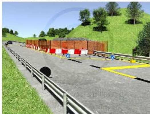
Dispositivo di cantiere con traffico alternato con semaforo
