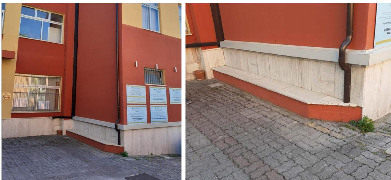
FIGURA 5.11 –GIUNTO TECNICO REALIZZATO TRA IL BLOCCO A ED IL CORPO SOTTOSTANTE, CON RIVESTIMENTO DELL'UNICA TRAVE RIMASTA
