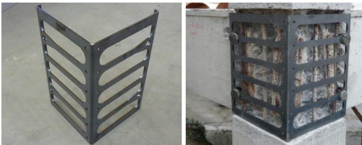
FIGURA 6.8 – ESEMPIO DI INSERTO METALLICO (FOTO SX) E POSA IN OPERA CON BARRE DI ANCORAGGIO CON TAPPO SALDATO (FOTO DX)
