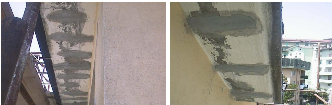
FIGURA 5.13 – LAVORI RELATIVI AL PROGETTO DI RINFORZO DEL '96: RIPRISTINO DEL COPRIFERRO AGGETTO DI COPERTURA
