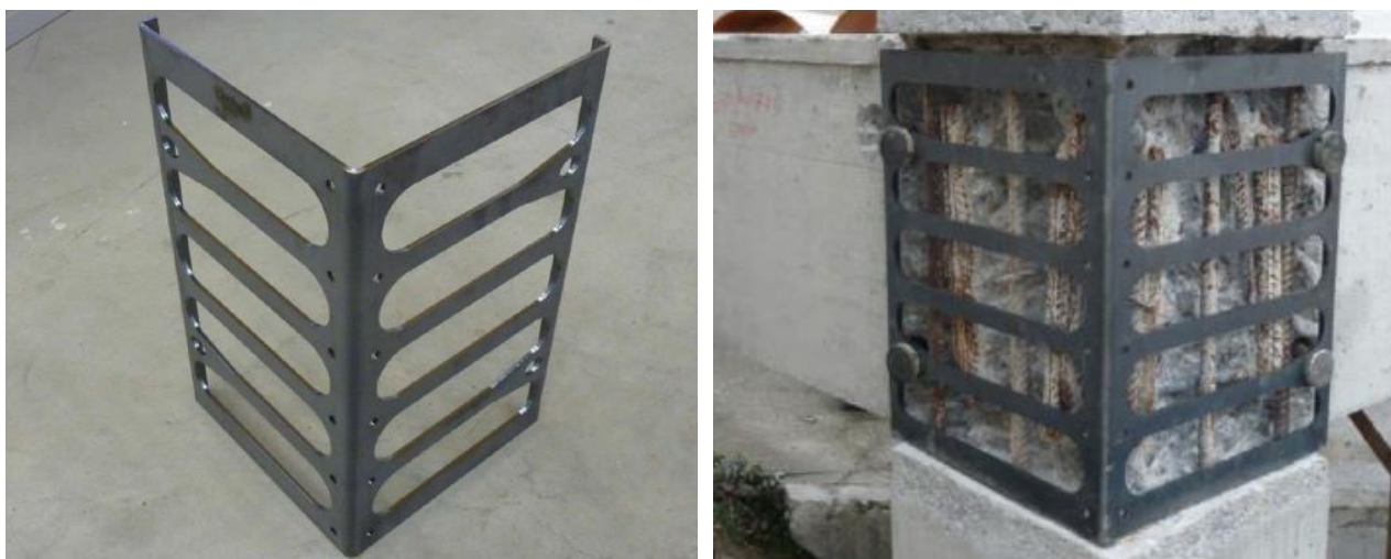
FIGURA 5.8 – ESEMPIO DI INSERTO METALLICO (FOTO SX) E POSA IN OPERA CON BARRE DI ANCORAGGIO CON TAPPO SALDATO (FOTO DX)
