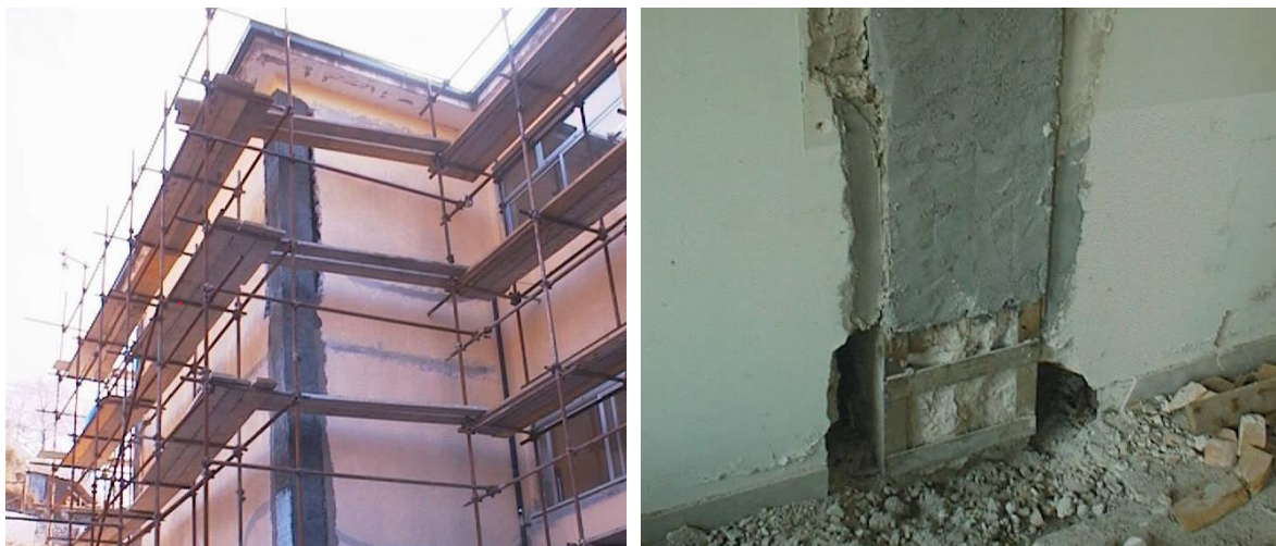
FIGURA 5.6 – EVIDENZA DELL'INTERVENTO DI CONFINAMENTO DEI PILASTRI VANO SCALA MEDIANTE CALASTRELLI ED ANGOLARI
