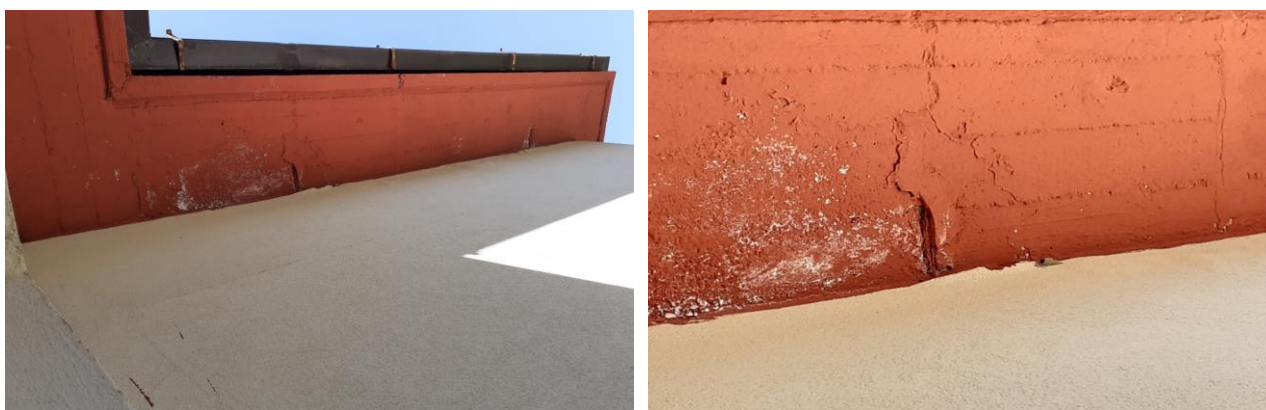
FIGURA 5.12 – FOTO SCATTATE DURANTE SOPRALLUOGO: SFOGLIATURA BARRE DI ARMATURA LONGITUDINALE AGGETTO DI COPERTURA
