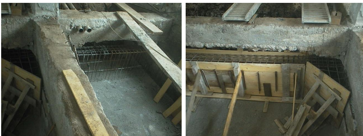
FIGURA 5.2 – ALCUNE IMMAGINI CHE MOSTRANO L'INTERVENTO DI RINFORZO IN FONDAZIONE
