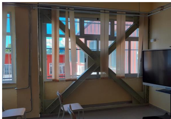
FIGURA 5.4 – INSERIMENTO DEI CONTROVENTI CONCENTRICI ALL'INTERNO DELLE MAGLIE DI TELAIO
