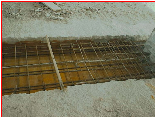
Realizzazione travi trasversali di piano
