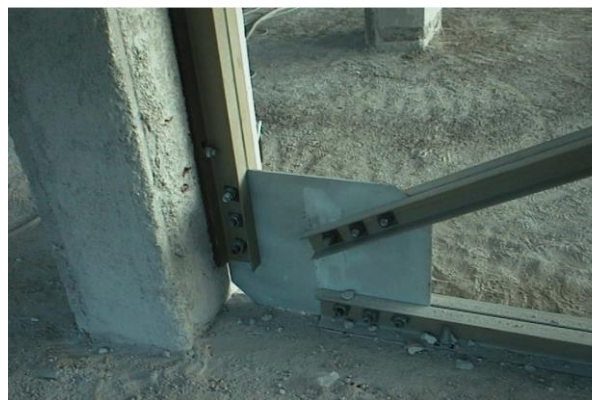
FIGURA 5.4 – INSERIMENTO DEI CONTROVENTI CONCENTRICI ALL'INTERNO DELLE MAGLIE DI TELAIO
