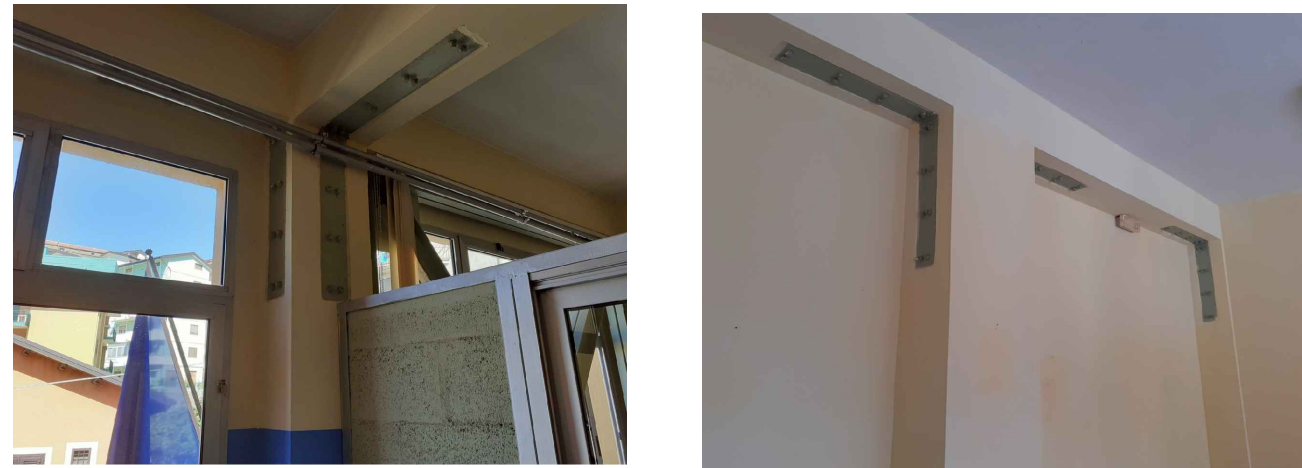
FOTO RINFORZO SEZIONI DI ESTREMITA' TRAVI E PILASTRI
