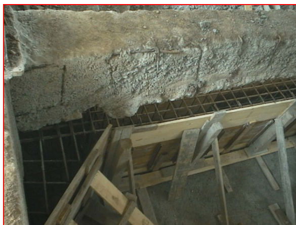
Intervento sulle travi di fondazione
