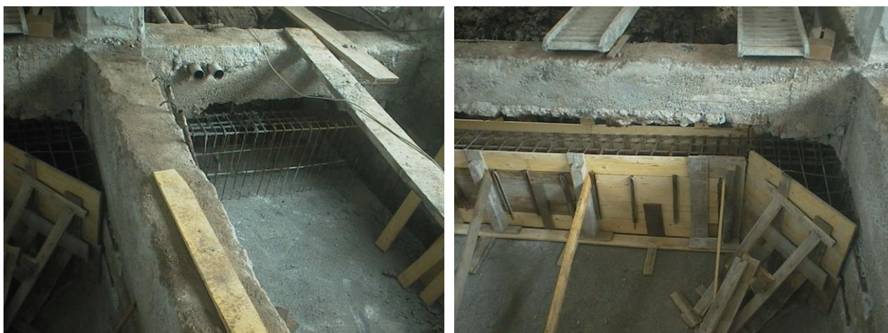
FIGURA 2.3 – ALCUNE IMMAGINI CHE MOSTRANO L'INTERVENTO DI RINFORZO IN FONDAZIONE
