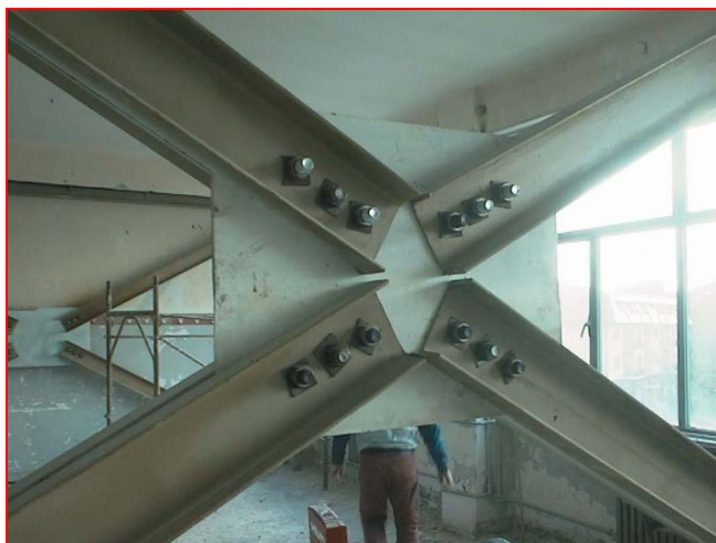
Controventi concentrici in acciaio
