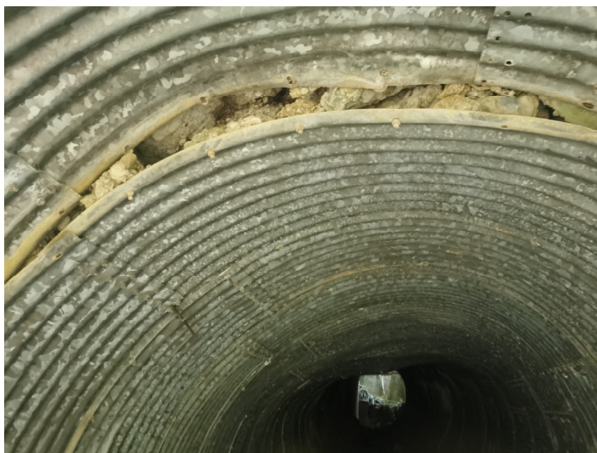
Nella foto: Interno del tubo ARMCO in corrispondenza della progressiva Km 7+300: si vede chiaramente la deformazione dello stesso per schiacciamento (in secondo piano) e la perdita di continuità per scollamento tra le parti.
