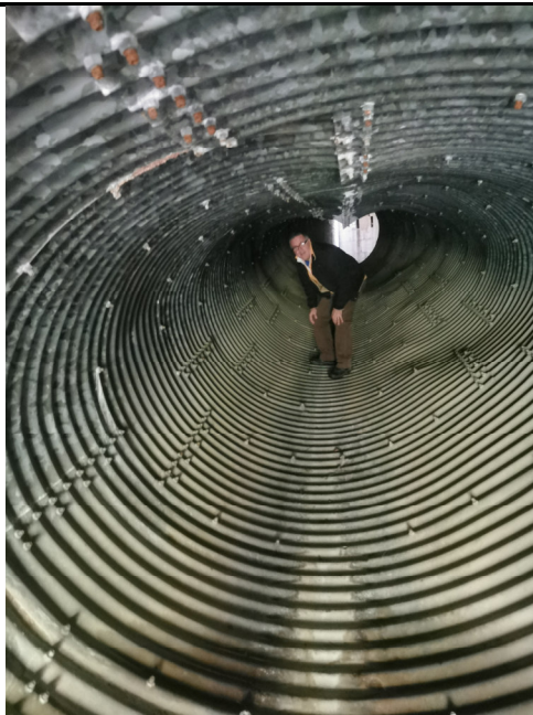
Nella foto: Interno del tubo ARMCO in corrispondenza della progressiva Km 7+450: si vede chiaramente la deformazione con ovalizzazione dello stesso per schiacciamento.
