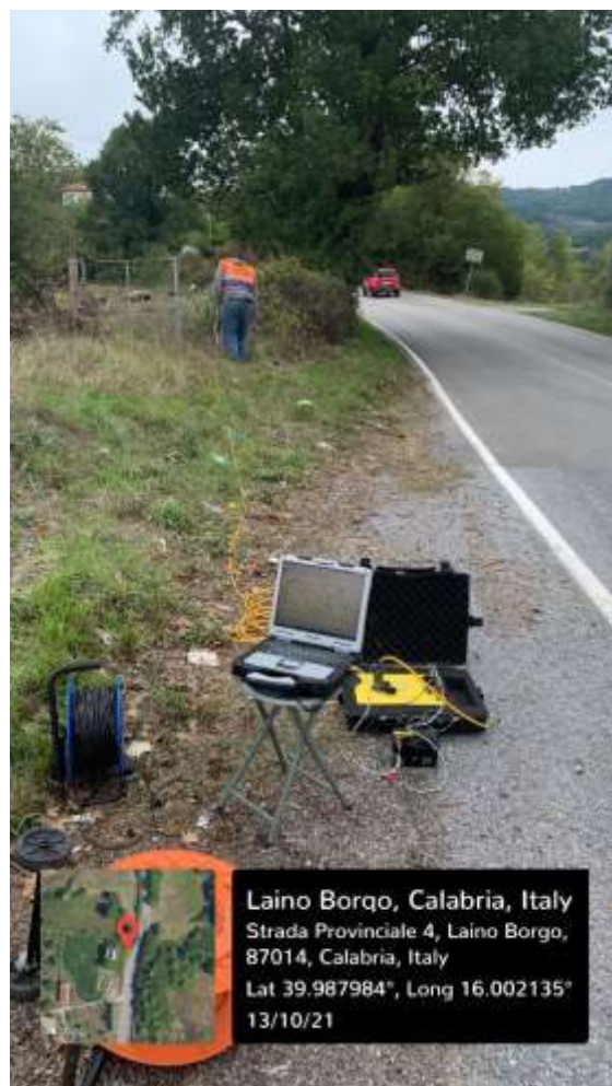
Foto n. 34: fase esecutiva prospezione sismica masw
