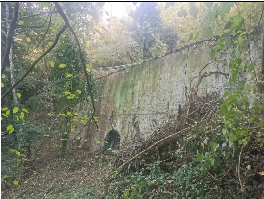
Nella foto: muro di controripa e fuoriuscita tubo ARMCO in corrispondenza della progressiva Km 6+500.
