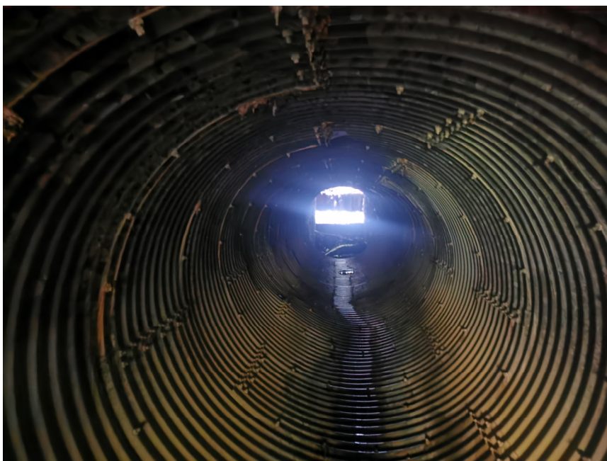
Nella foto: interno del tubo ARMCO in corrispondenza della progressiva Km 6+500, invero in questa posizione solo leggermente deformato
