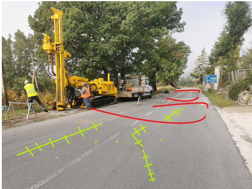
Nella foto mammellonature del terreno(rosso) e crepe sull' asfalto (verde) in corrispondenza del tratto in dissesto.
