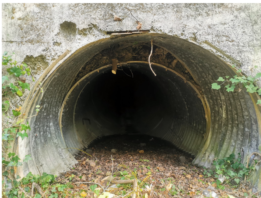
Nella foto: Interno del tubo ARMCO in corrispondenza della progressiva Km 7+150: si vede chiaramente la perdita di continuità della tubazione per crollo della stessa per schiacciamento appena subito dopo l'attacco della testa al muro di controripa.
