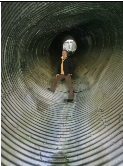
Nella foto: Interno del tubo ARMCO in corrispondenza della progressiva Km 7+300: si vede chiaramente la deformazione dello stesso per schiacciamento.
