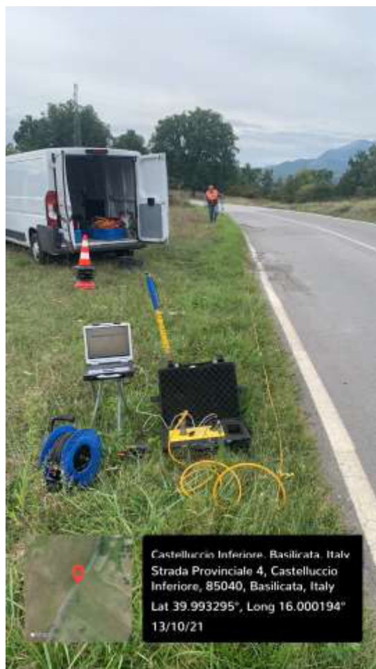
Foto n. 27: fase esecutiva prospezione sismica a rifrazione in onda P
