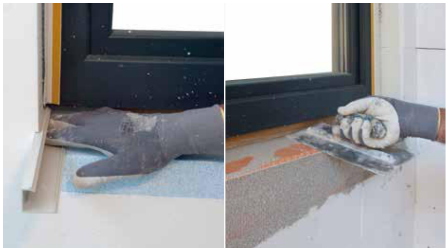
Incollare il profilo ad intonaco per davanzale RÖFIX SOL-PAD utilizzando RÖFIX Adesivo impermeabilizzante Polymer, quindi impermeabilizzare la zona di alloggiamento del davanzale con RÖFIX OPTIFLEX®
