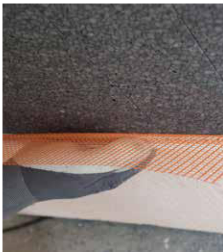
Inserire il profilo ad innesto per zoccolatura RÖFIX
