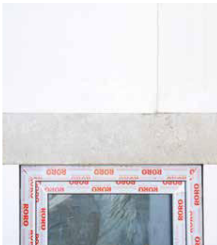
Disposizione sopra l'architrave delle finestre con una Fascia di compartimentazione antincendio sporgenza laterale di 30 cm e un'altezza di 20 cm
