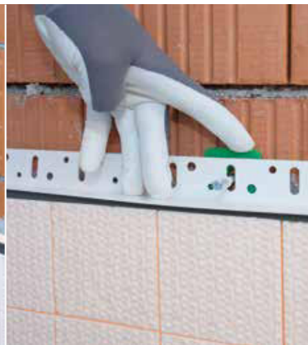
Allineare il profilo di partenza e pareggiare le irregolarità con i distanziatori
