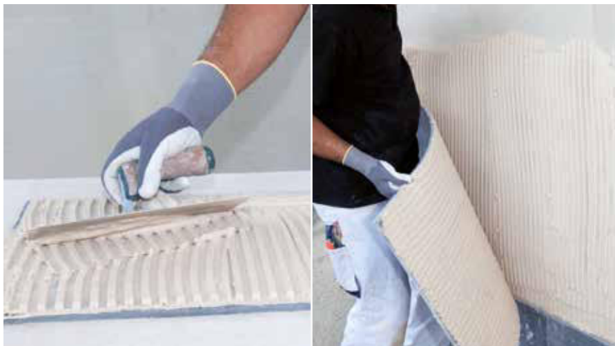
Applicare il collante sul pannello isolante ed applicare anche sul supporto e posizionare il pannello isolante
