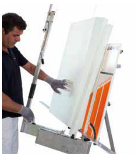
Tagli obliquo a 45° del pannello isolante della zoccolatura
