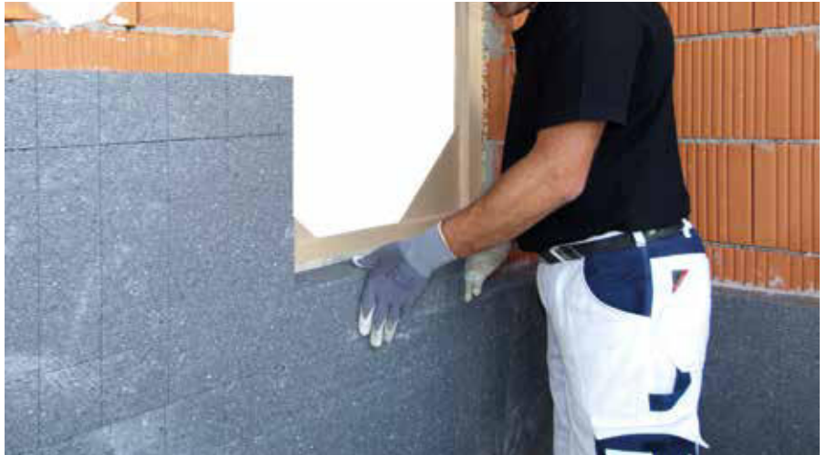
In corrispondenza delle aperture, applicare i pannelli isolanti interi opportunamente tagliati a L
