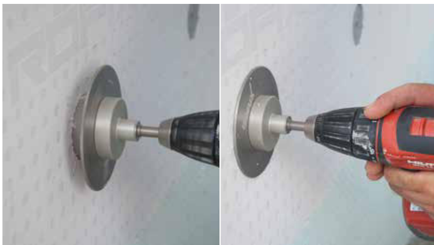
Montaggio a incasso: Inserire bene il BIT nell'alloggiamento Torx fino allo scatto di aggancio, poi lasciare che il tassello si „autoavviti“ (senza fare pressione).
