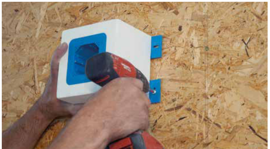
Fissare con le viti l'elemento.
