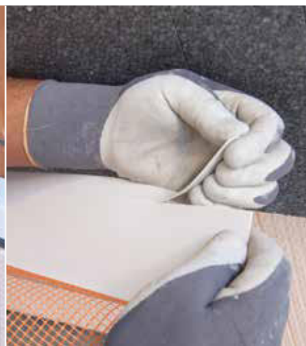
Regolare il profilo ad innesto per zoccolatura RÖFIX in base allo spessore dell'isolante
