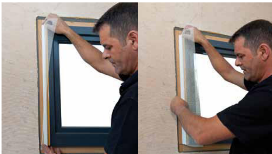
Posizionare il profilo ad angolo retto ed incollare sul telaio in legno sottostante
