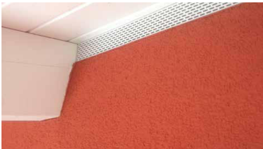
RÖFIX Profilo di raccordo a soffitto installato ed intonacato
