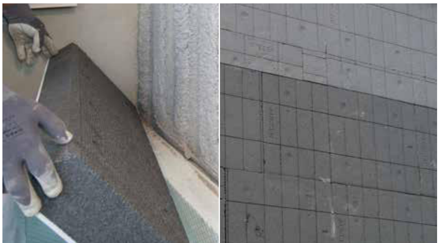
Premere i pannelli isolanti nel collante fresco utilizzando la zigrinatura take-it
