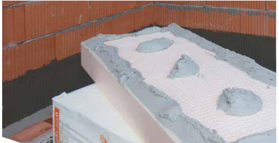
Incollare il pannello isolante di zoccolatura RÖFIX EPS-P con RÖFIX OPTIFLEX® con il metodo a cordolo perimetrale e punti centrali
