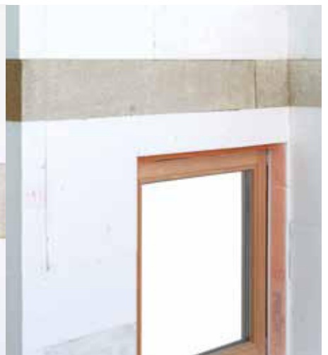
Disposizione sopra l'architrave delle finestre con una Fascia di compartimentazione antincendio sporgenza laterale di 30 cm e un'altezza di 20 cm
