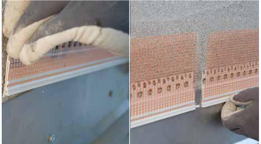
Inserire RÖFIX BAP sulla lamiera lasciando 1cm gioco tra lamiera e l'arresto
