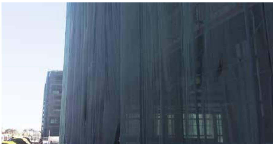
La rete protettiva della facciata protegge i materiali appena applicati dai agenti atmosferici esterni e da un'asciugatura troppo rapida
