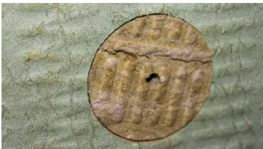
Coprire il tassello con RÖFIX Rondella di copertura MW
