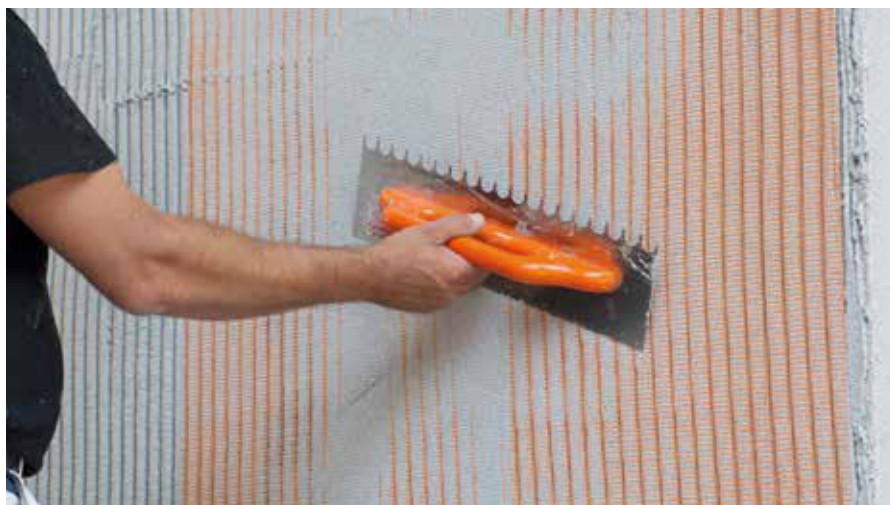
Applicare RÖFIX Unistar® LIGHT in uno spessore nominale di 5 mm ed annegare la rete di armatura RÖFIX P50
