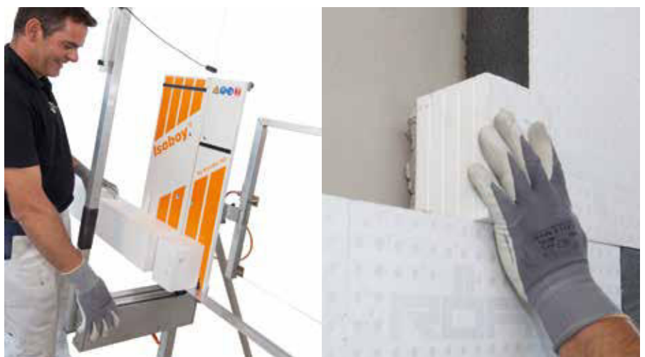
Tagliare RÖFIX Quick-Quader con RÖFIX ISOBOY GD 34 e incollarlo al supporto con collante e rasante del sistema.
