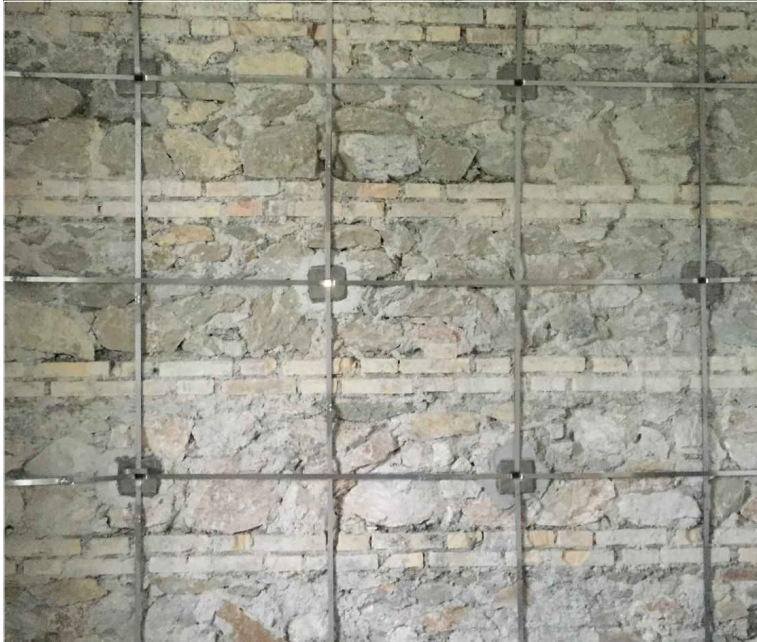
FOTO ESECUZIONE CAM SU QUINTA NEL SOTTOTETTO
