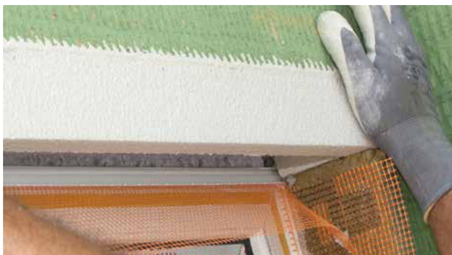
Incollare a superficie piena l'elemento di intradosso sulla superficie e tassellare a sinistra e a destra dei lati esterni
