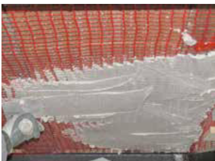
APPLICAZIONE DELL'INTONACO STRUTTURALE
