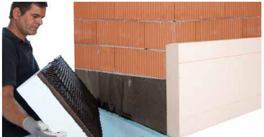
Incollare a superficie piena il pannello isolante per zoccolatura RÖFIX EPS-P 035 sulla guaina bituminosa utilizzando RÖFIX 1K Plus
