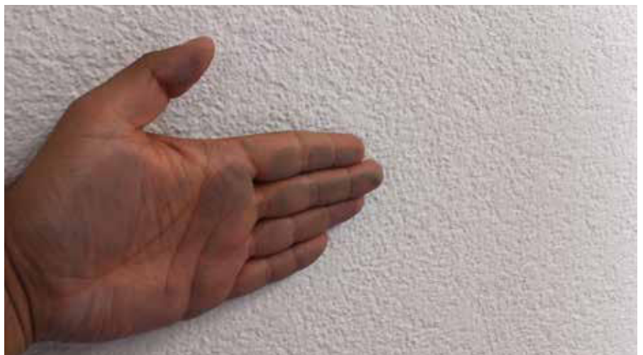
Rimuovere i supporti polverosi, gessosi e dare una mano di idoneo fissativo (RÖFIX PP 201 SILICA LF o RÖFIX PP 301 HYDRO LF opportunamente diluiti). Rimuovere meccanicamente le finiture a base calce
