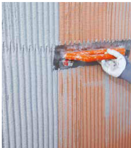
Eseguire il rasante in uno spessore nominale di 5 mm
