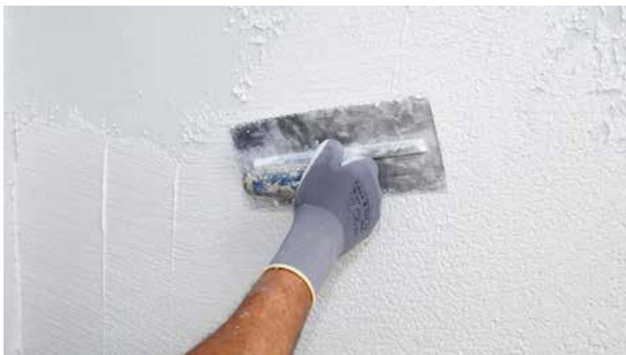
Applicare RÖFIX Rivestimento SiSi® bianco e strutturare
