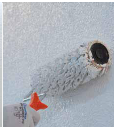
Rivestimento con pitture permeabili al vapore
