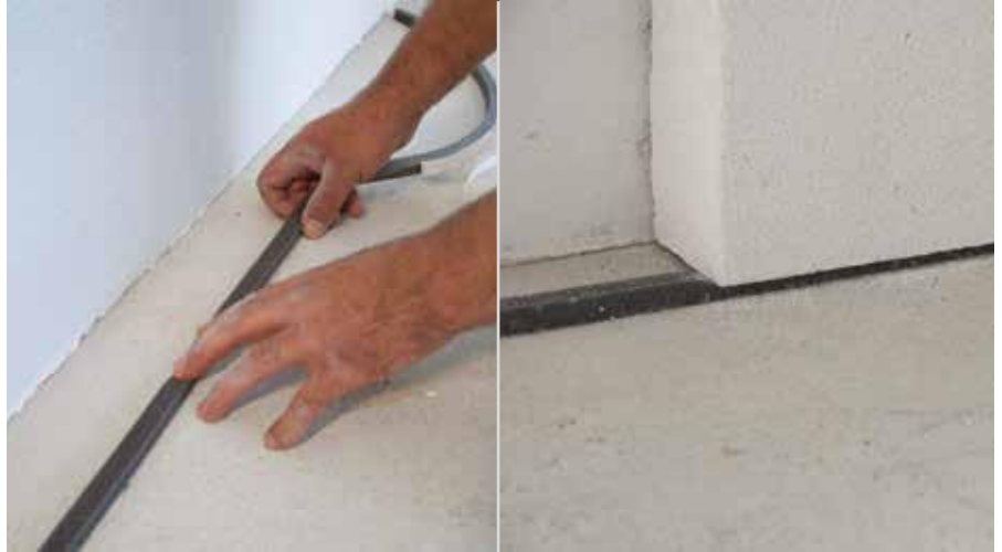
Chiudere con RÖFIX Nastro di guarnizione il sistemi isolante per interni contro il pavimento, la parete ed il soffitto.
