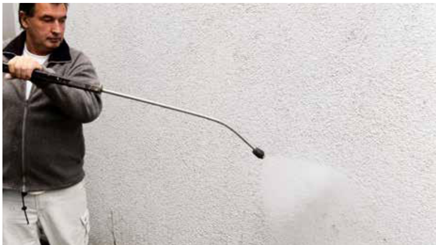
Lavare la facciata con idropulitrice e lasciar asciugare
