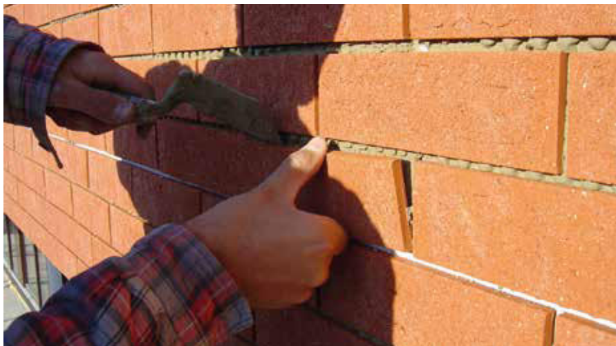
Incollare le mattonelle a piena superficie con metodo floating-buttering
