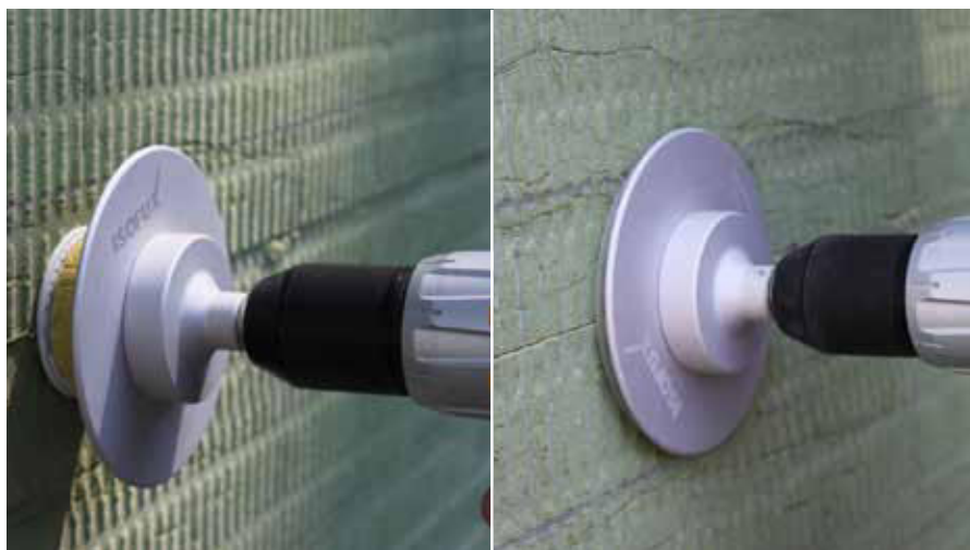
Affondare il tassello fino alla battuta utilizzando il tool RÖFIX ISOFUX OPTI
