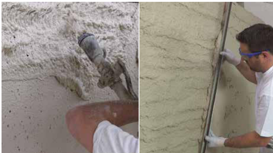
Applicazione dell'intonaco FIXIT 222 Aerogel
