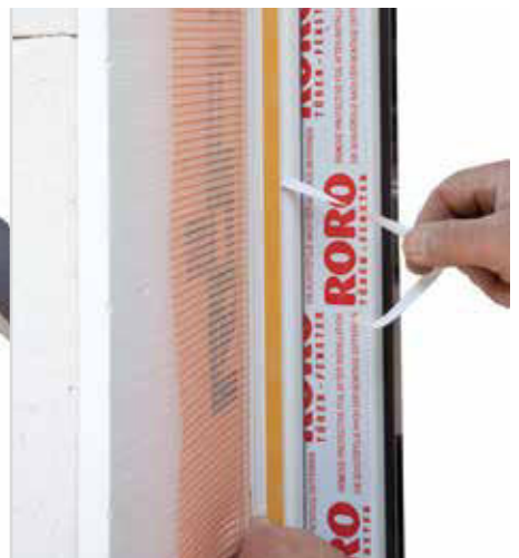
Incollare RÖFIX MINI 3D sul telaio della finestra e proteggere la finestra prima della rasatura
