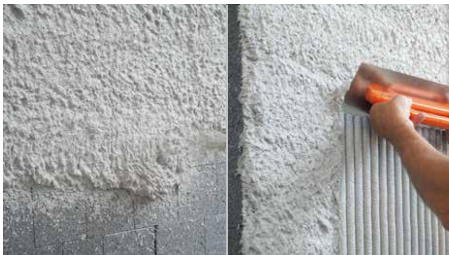
Applicare il rasante a spruzzo con intonacatrice.
