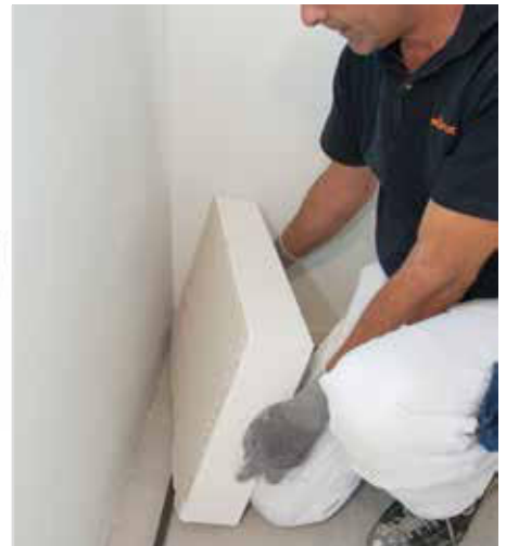
Applicazione sull'intera superficie di RÖFIX MINOSTAR® Premere bene i pannelli isolanti
