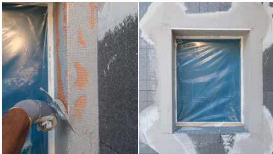
Annegare la rete angolare fresco su fresco nello strato di rasatura.
