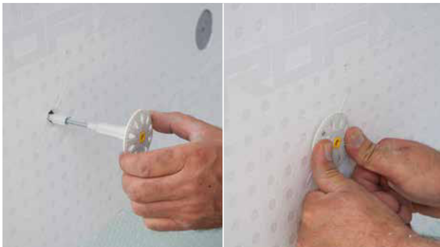
Montaggio a incasso: Inserire RÖFIX ROCKET nel foro. La testa del tassello deve essere posizionata a filo del pannello isolante.
