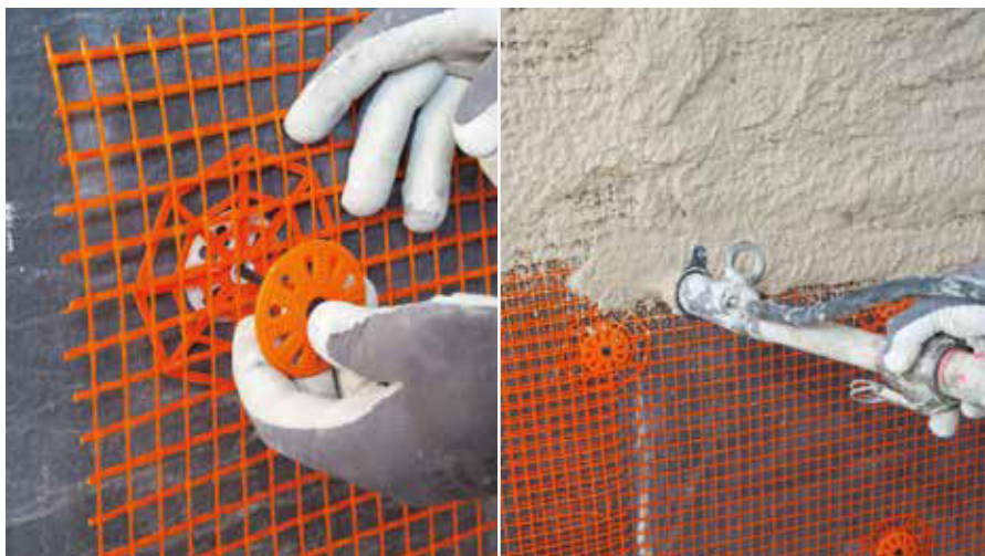
Fissare la rete di supporto RÖFIX IG 996 con RÖFIX BTH e RÖFIX NDF
