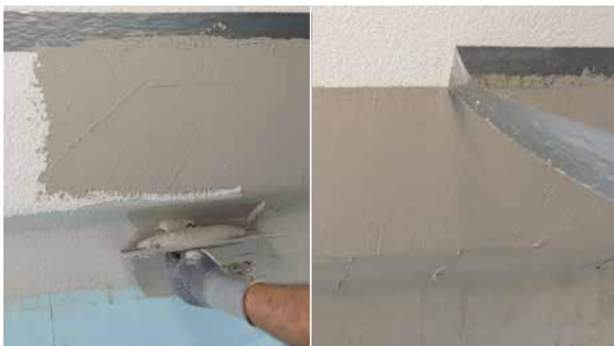
Impermeabilizzare la rasatura armata con rivestimento utilizzando RÖFIX OPTIFLEX®
