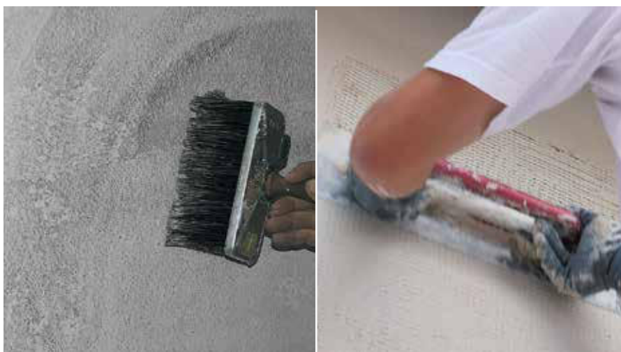
Fissaggio della superficie con RÖFIX PP 201
