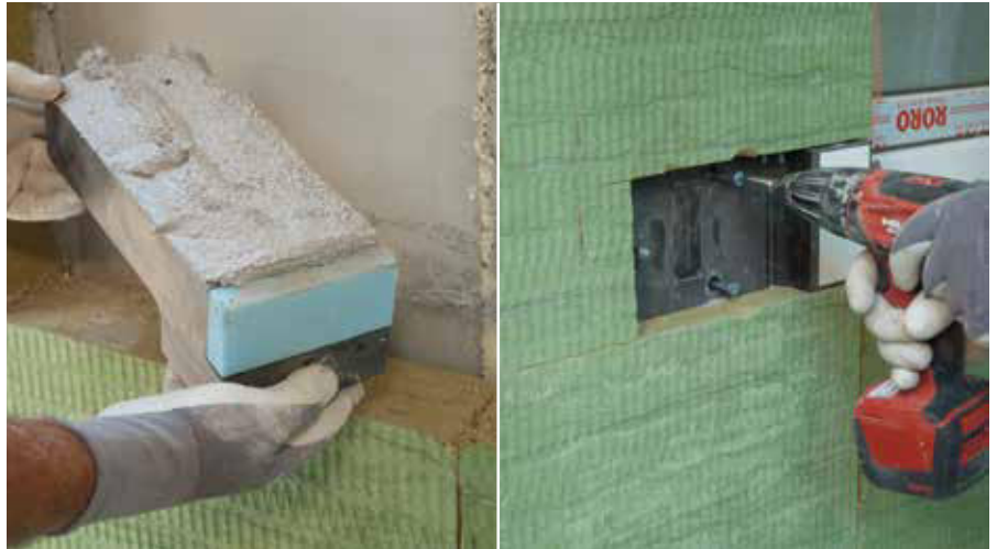
Incollaggio a piena superficie di RÖFIX K1-PH.
