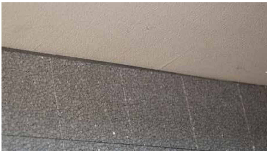
Durante l'incollaggio premere bene il pannello isolante della facciata contro il nastro di guarnizione in modo che venga compresso
