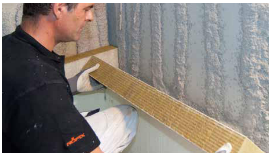
Applicare bene i pannelli isolanti RÖFIX SPEED MW premendoli nelle strisce di collante fresco
