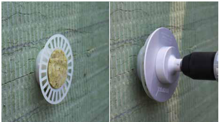
Inserire il tassello con il piatto nel foro e avvitare, quindi coprire con la rondella in lana di roccia.
