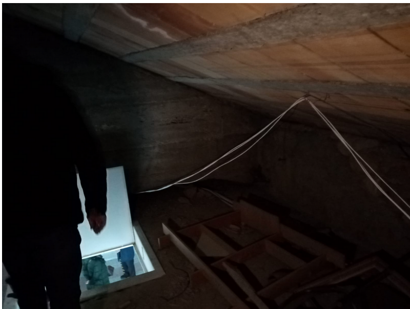
fig.3: setto in cemento armato e orditura del solaio di copertura
