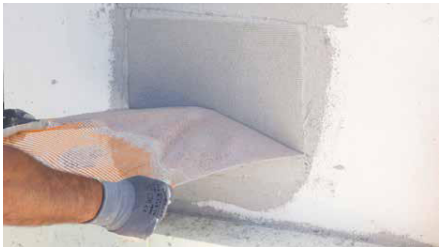
Rimuovere la rete di armatura RÖFIX P50
