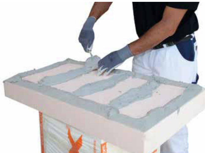
Superficie di incollaggio min. 60 %
