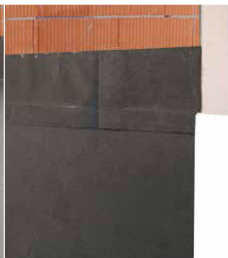
Impermeabilizzazione della muratura controterra con guaina bituminosa
