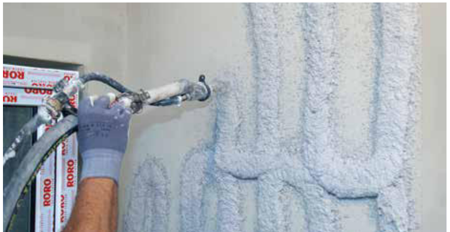
Assicurarsi che la parte inferiore del cordolo di collante chiuda la cavità in basso. In questo modo si evita ricircoli d'aria sul retro del sistema
