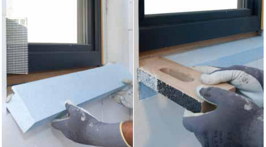
Incollare RÖFIX SOL-PAD-BASE e intagliare la scanalatura per l'alloggiamento del profilo con RÖFIX SOL-PAD Tool
