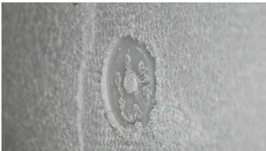
Tassellare attraverso lo strato di rasatura con rete ancora fresca
