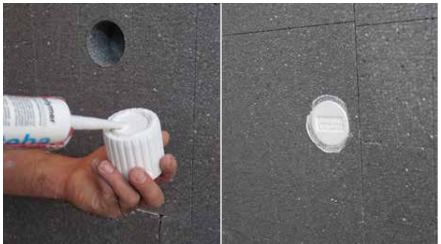
Applicare la colla PU sul retro di ZyRillo e sulle pareti laterali nel foro.
