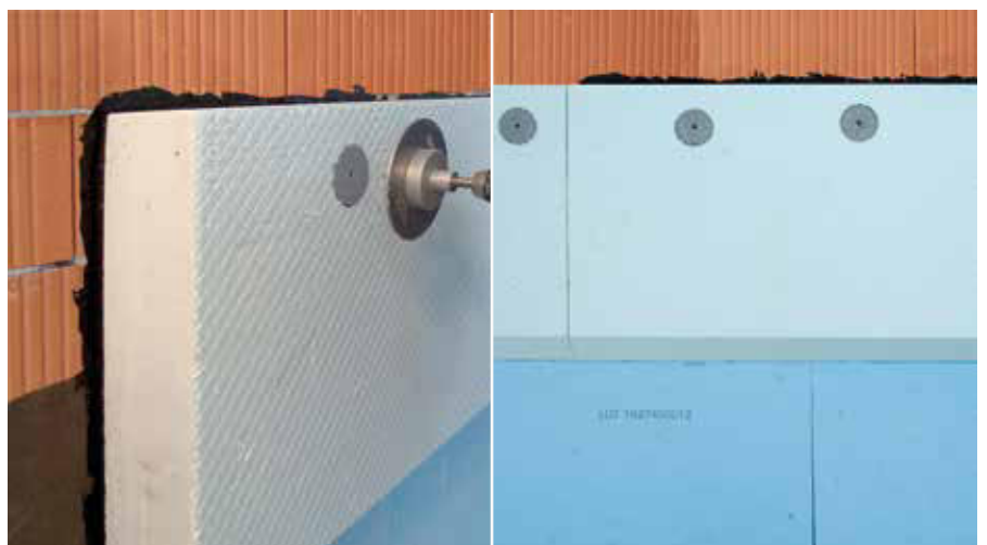
Fissare i pannelli isolanti di zoccolatura oltre il livello superiore dell'impermeabilizzazione con 2 tasselli per pannello
