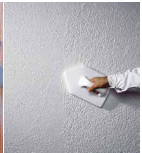
Dopo un adeguata asciugatura del rasante applicare il rivestimento murale e strutturare
