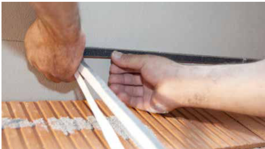
Incollare il nastro di guarnizione RÖFIX sulla parte sottostante del balcone o copertura
