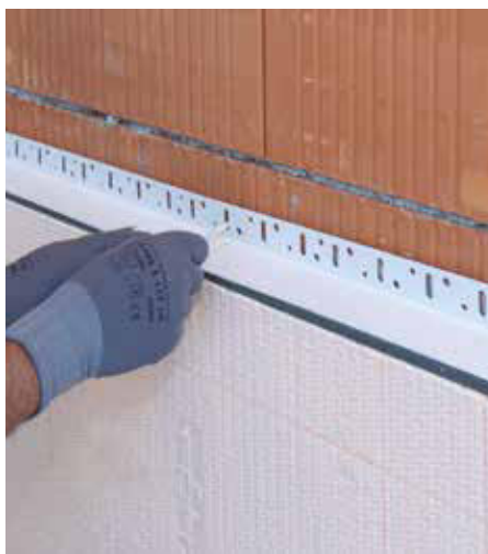
Fissaggio di RÖFIX Profilo base per zoccolature con tasselli ogni 30 cm
