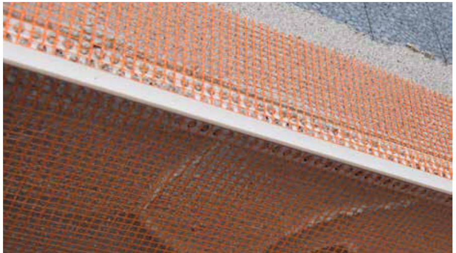
Annegare il profilo di gocciolamento nel rasante applicato a piena superficie
