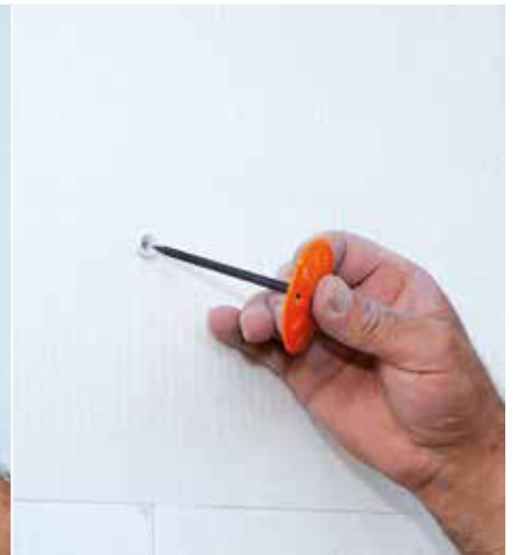
Fissare con RÖFIX NDF e RÖFIX BTH
