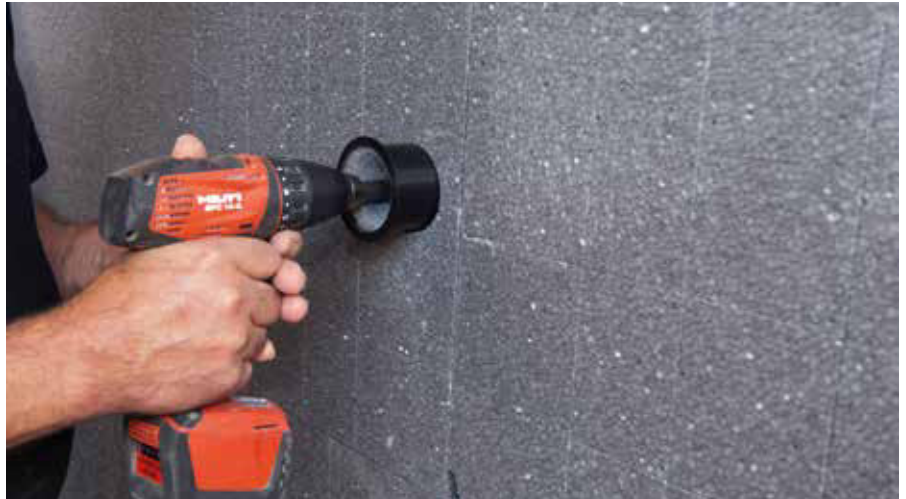
Fresare fino ad andare in battuta con la fresa ZyRillo.
