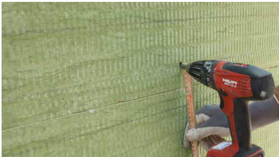
I pannelli in lana minerale vengono tassellati ad una distanza di 5 cm dallo spigolo esterno del pannello
