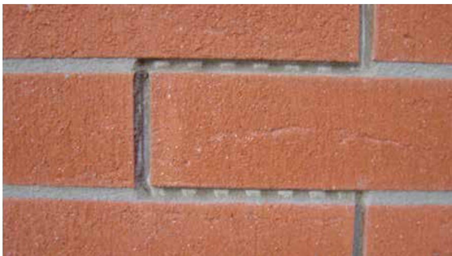
Giunto flessibile: Eliminare il collante fresco fino all'intonaco di fondo. Utilizzare idoneo stucco flessibile poliuretanico (es. Sika- Primer 3N e stucco Sikaflex Pro2HP)
