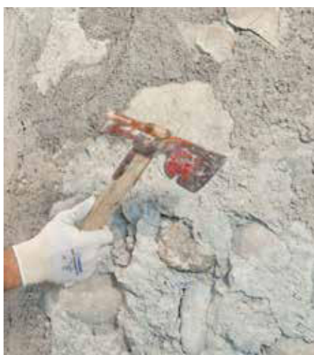
Eliminazione dell'intonaco vecchio
