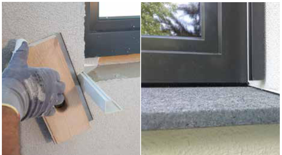
Rifilare il profilo di delimitazione RÖFIX SOL-PAD con l'attrezzo RÖFIX SOL-PAD Tool lasciando 2 mm di sporgenza e quindi montare il davanzale
