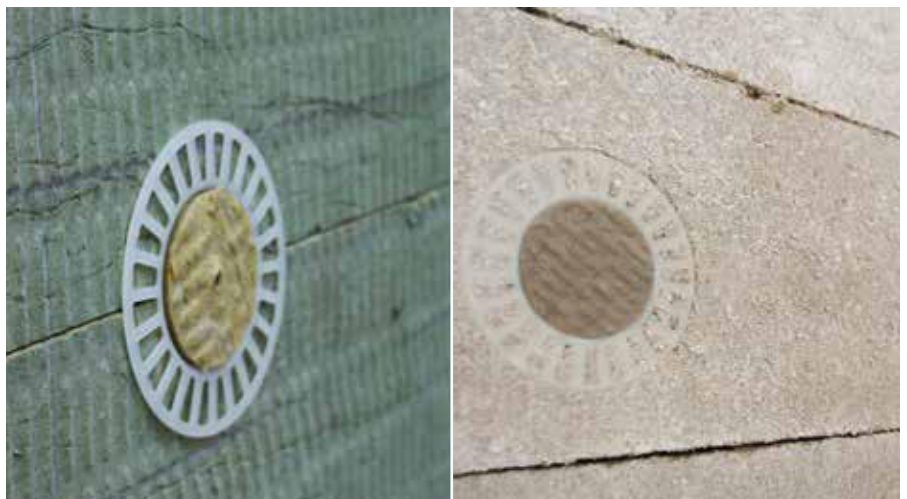
I pannelli isolanti lamellari in lana minerale possono essere tassellati senza problemi utilizzando il tassello per incasso RÖFIX MW CUP
