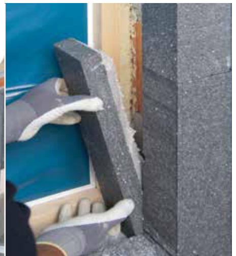
In corrispondenza delle aperture, applicare i pannelli isolanti interi opportunamente tagliati a L
