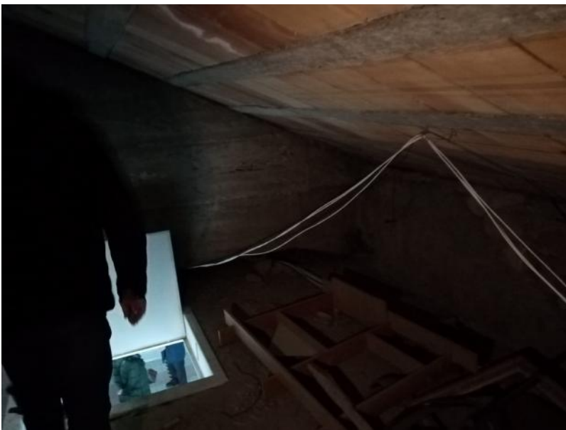
fig.3: setto in cemento armato e orditura del solaio di copertura
