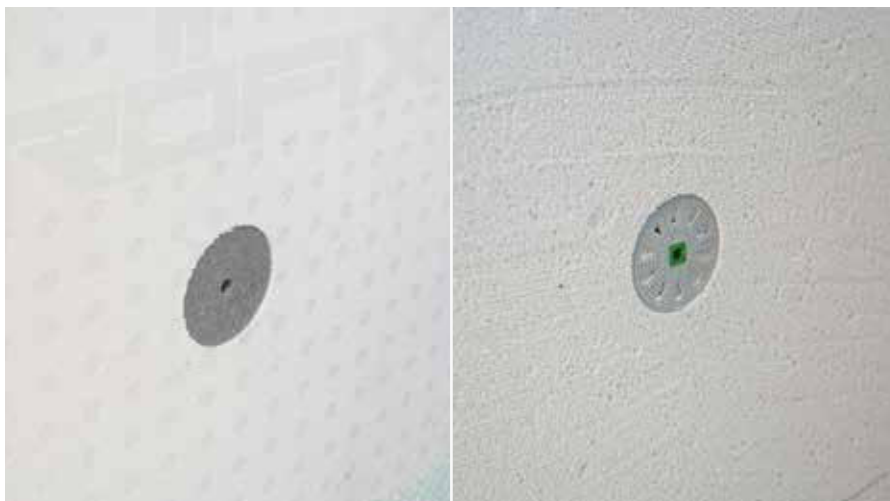
RÖFIX ROCKET montaggio a incasso con rondella di copertura in EPS.
