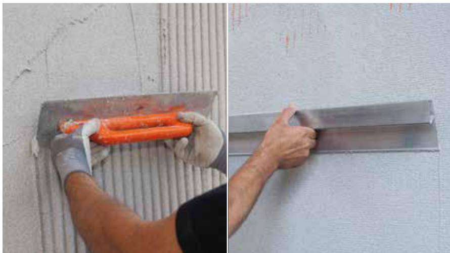
Stendere il rasante e distribuirlo con cordoli verticali uniformi e annegare la rete di armatura RÖFIX P50. Con la spatola liscia è possibile tirare una superficie planare.
