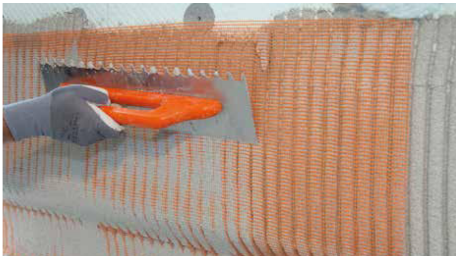
Annegare la rete di armatura RÖFIX P50 nel collante e rasante di sistema
