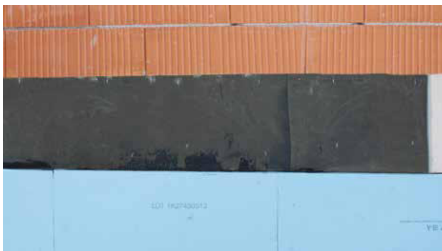
Pannelli isolanti perimetrali incollati con collante bituminoso RÖFIX 1K Plus
