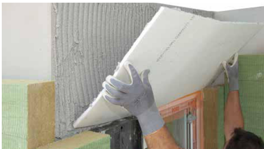
Incollaggio a superficie piena in metodo floating buttering del pannello RÖFIX Aerogel
