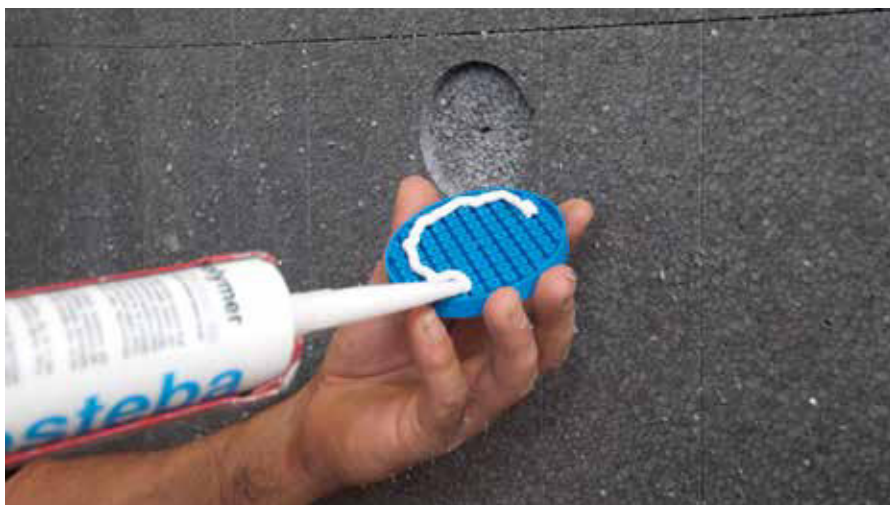
Applicare collante PU.
