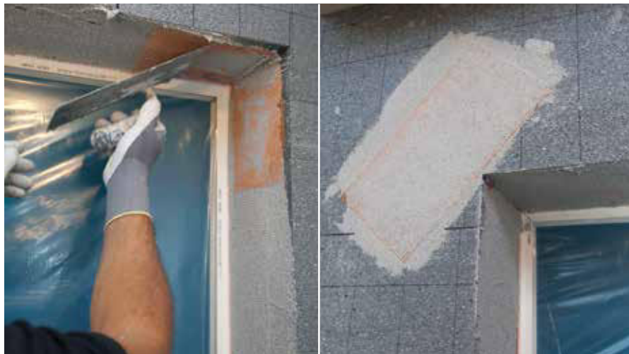
La rete di armatura RÖFIX P50 viene sempre annegata nel rasante fresco precedentemente steso sull'isolante.
