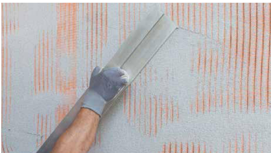
Annegare la rete di armatura RÖFIX P50 nel rasante fresco.
