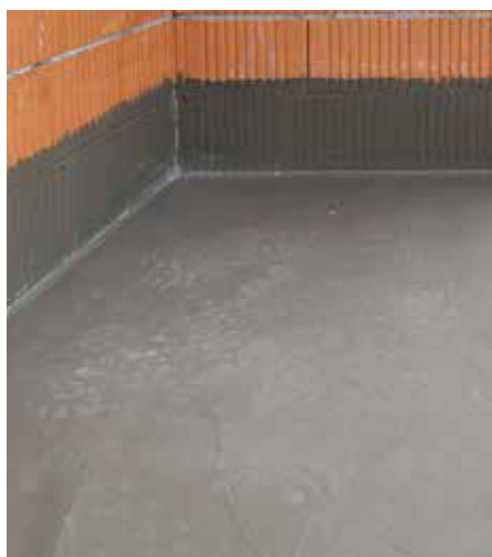
Impermeabilizzazione della muratura controterra e delle terrazze con RÖFIX Optiseal®
