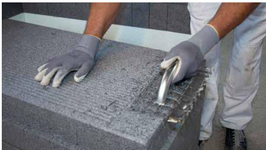
In corrispondenza degli angoli dell'edificio, rettificare la zigrinatura take-it
