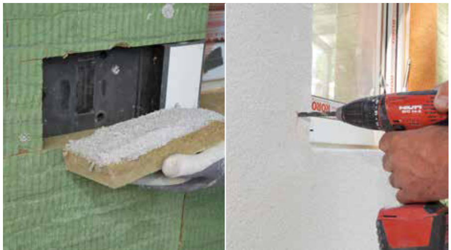
Incollare/coprire i tasselli con un pannello isolante.
