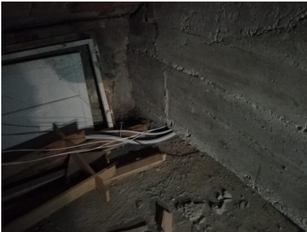
fig.4: dettaglio di appoggio del setto in cemento armato a sostegno della copertura
