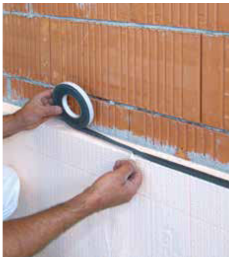
Incollare il nastro di guarnizione sul pannello della zoccolatura (filo esterno)
