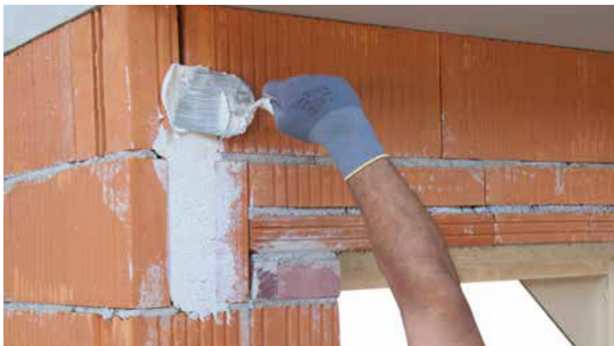
Chiusure i fori e le fessure con RÖFIX 510 oppure RÖFIX Renoplus®
