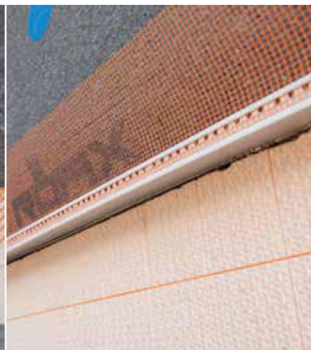
Regolare il profilo ad innesto per zoccolatura RÖFIX in base allo spessore dell'isolante
