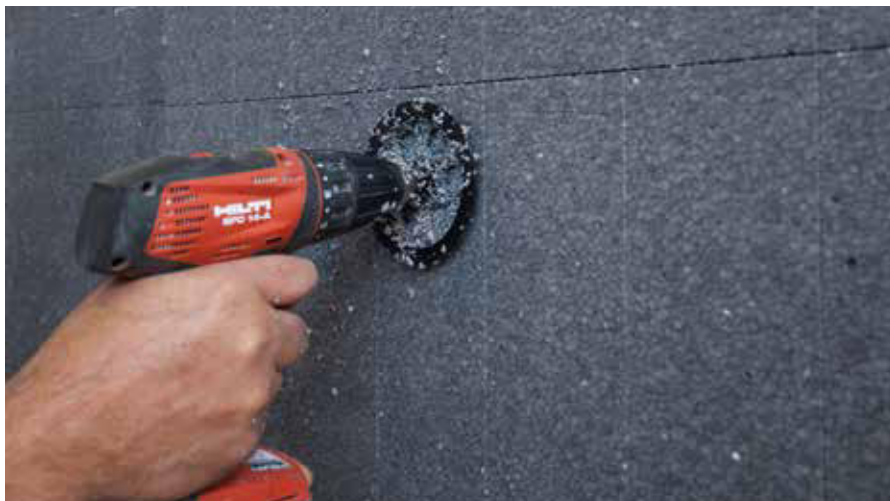
Fresare con la fresa DoRondo fino ad andare in battuta.
