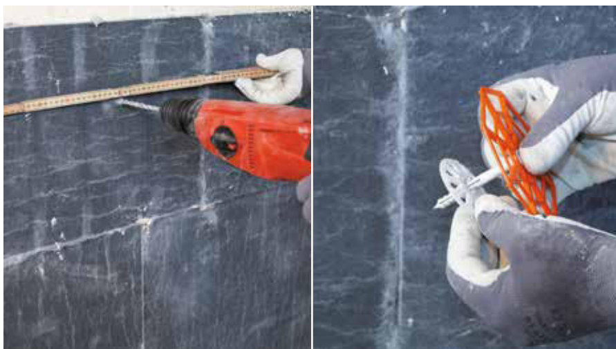
Posizionare i tasselli secondo un reticolo di 40x40 e montare secondo istruzioni contenute nell'imballaggio
