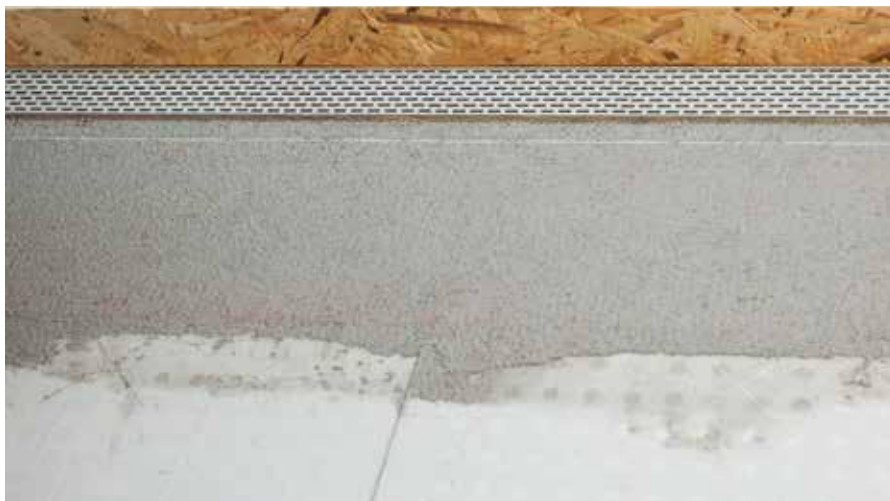
Incollare RÖFIX Profilo di raccordo a soffitto ed annegare nel rasante applicato a superficie piena
