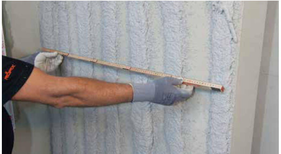
Spruzzare i cordoli di collante sul supporto con una larghezza di 5-6 cm e una distanza di 17 cm tra le mezzerie
