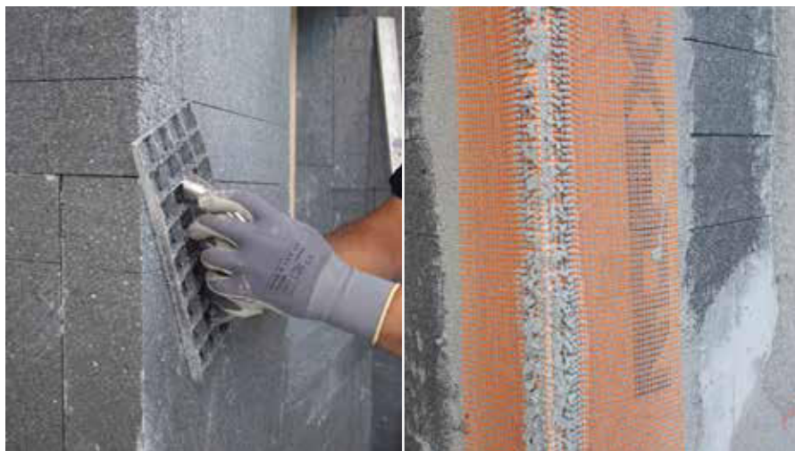
Levigare sporgenze di pannelli isolanti.
