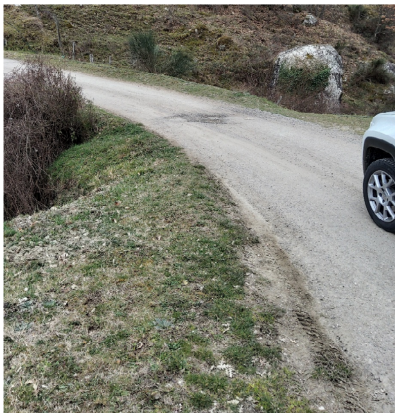
Figura 7: Sgranamento del rivestimento e ormaie – Tratto 12 (sopra tombino)
