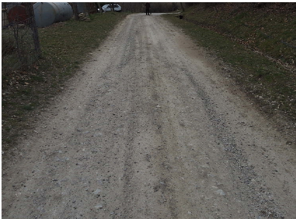
Figura 8: Disfacimento fondazione e rivestimento- Tratto 16
