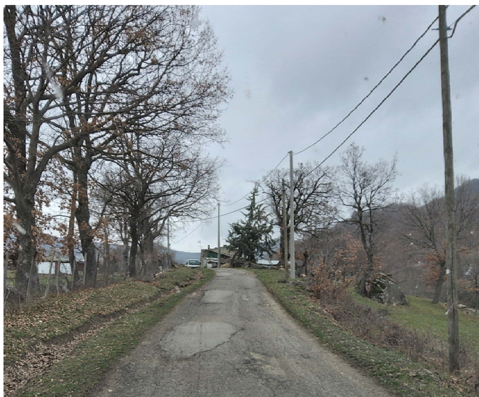
Figura 9: Sgranamento del rivestimento e ormaie - Tratto 20
