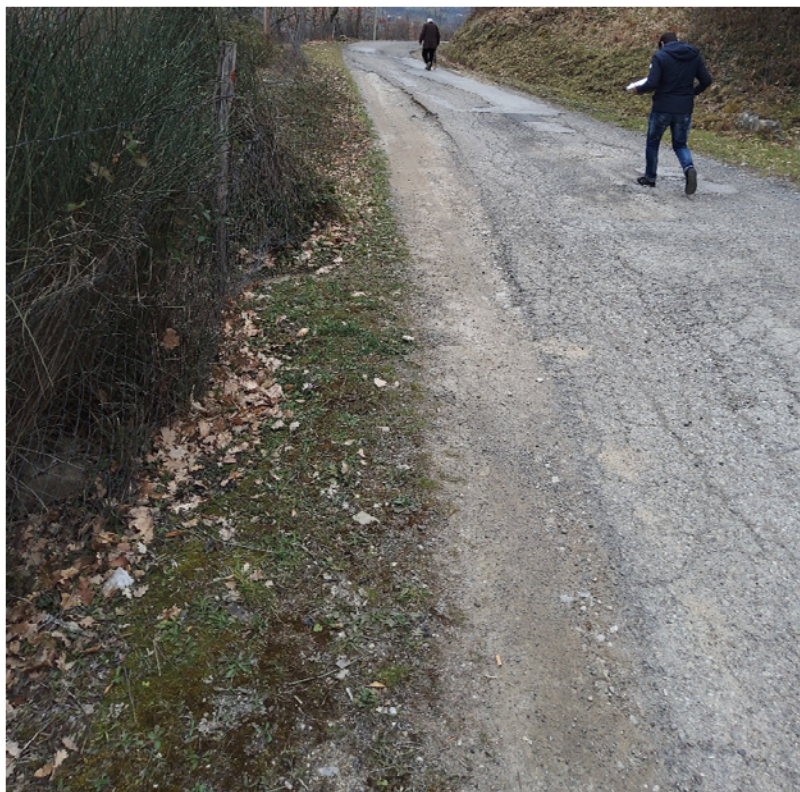
Figura 4: Fessurazioni longitudinali – Tratto 5
