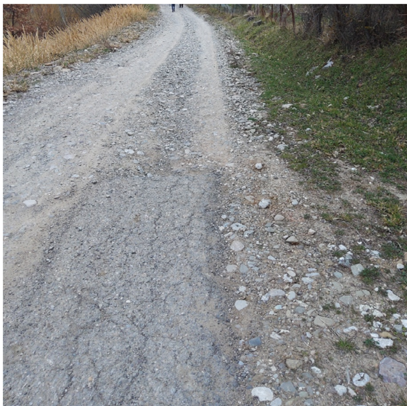
Figura 3: Disfacimento asfalto e fondazione stradale – Tratto 3
