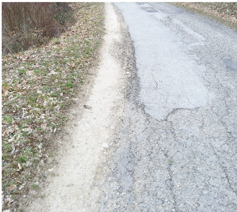
Figura 5: Fessurazioni longitudinali– Tratto 6
