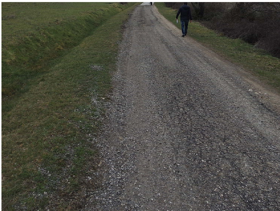
Figura 10: Sgranamento del rivestimento e tratti di disfacimento fondazione - Tratto 29
